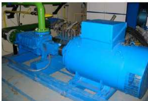
Photo 1 pompe d'enneigement (moteur + pompe)
